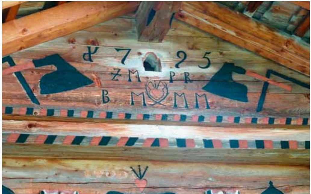
Frontseite des Speichers im Farnigenboden (Axalp).
