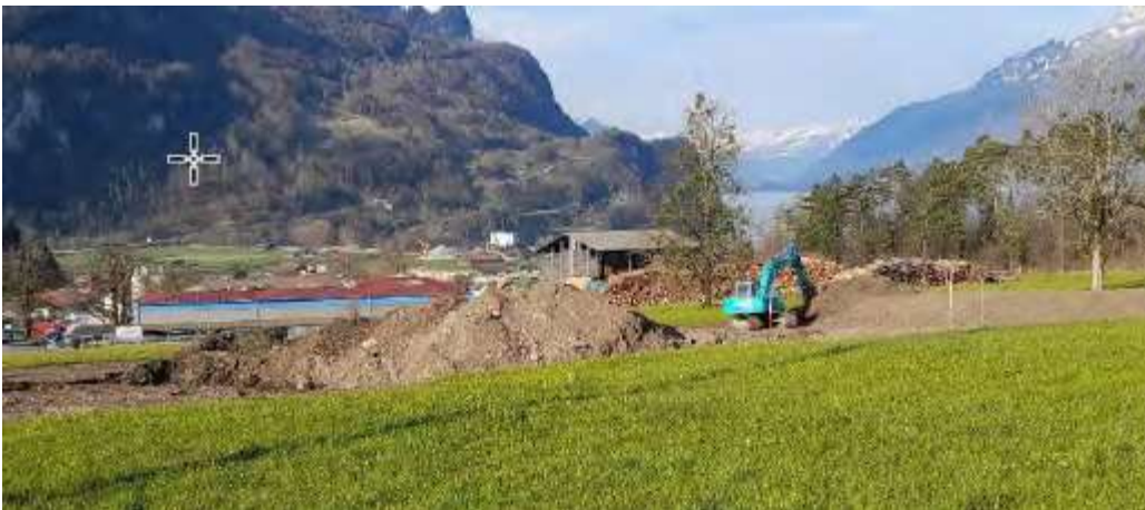
Sanierung Umschlagplatz Lauenen
