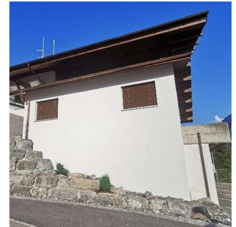
Büroanbau DLZ (Forst/Bau)
