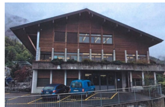
Sanierung Fassade Süd/Ost DLZ Glyssibach
