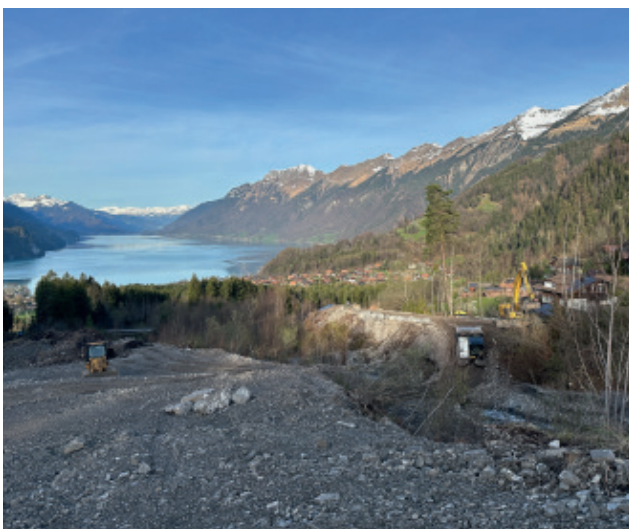
Terrainabsenkung und Leitdamm Gummbiel
