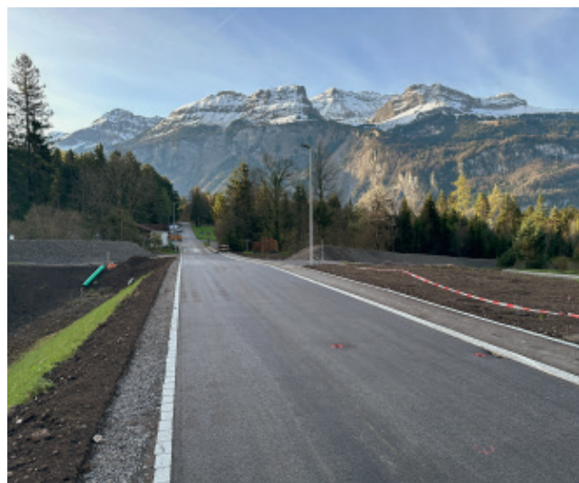
Angehobene Schwanderstrasse nach dem Einbau der Deckschicht
