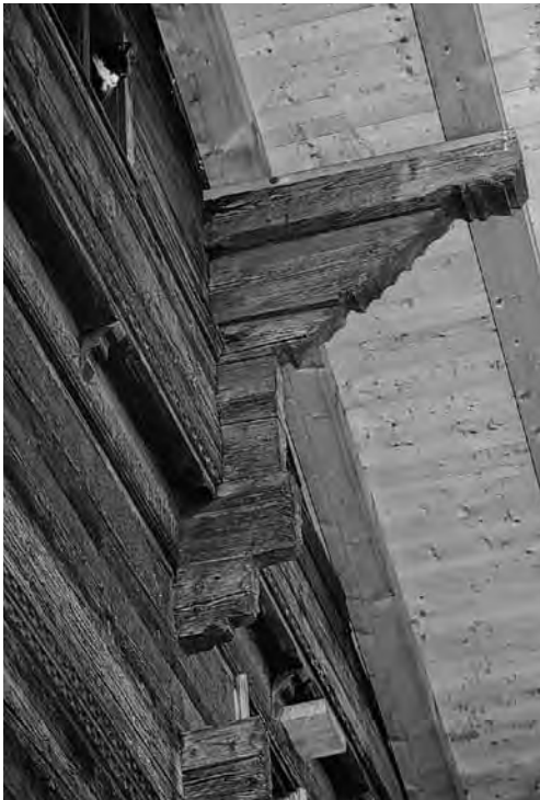
Der kräftige Vorkrag des Giebfeldes am Haus an der Äusserstgasse 3, wo bei genauem Hinsehen immer noch feine Rillenfriese, wie sie im 16. Jahrhundert Mode waren, zu erkennen sind. Typisch für die Bauzeit von 1644 ist die abgeschrägte Blockkonsole mit den halbkreisförmigen Aushüben.
