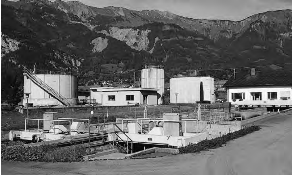
Die ARA mit Stapelbehälter für hygienisierten Schlamm, Faulturm, Nachklärbecken und Betriebsgebäude.
