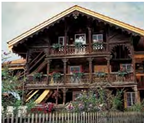
Der ostseitige Anbau der Apotheke an derselben Strasse als reichstes Beispiel des Schweizer Holzstils in unserem Dorf.
