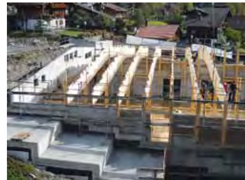
Zimmermannskunst: Montage der imposanten Dachträger im Spätsommer 2009.
