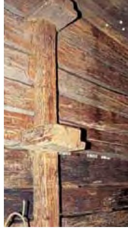
Die Stallscheune an der Äusserstgasse, deren Blockwand mit den «Schliessen», so nannte man in Brienz diese Vorrichtung mit Keilbalken und Klammer, gesichert ist. Rechts daneben: Dieselbe Wand von der Innenseite gesehen.
