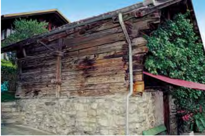
Die Stallscheune an der Äusserstgasse, deren Blockwand mit den «Schliessen», so nannte man in Brienz diese Vorrichtung mit Keilbalken und Klammer, gesichert ist. Rechts daneben: Dieselbe Wand von der Innenseite gesehen.
