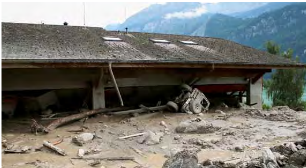
Altes Feuerwehrmagazin am Glyssibach mit Unwetterschäden (August 2005).
