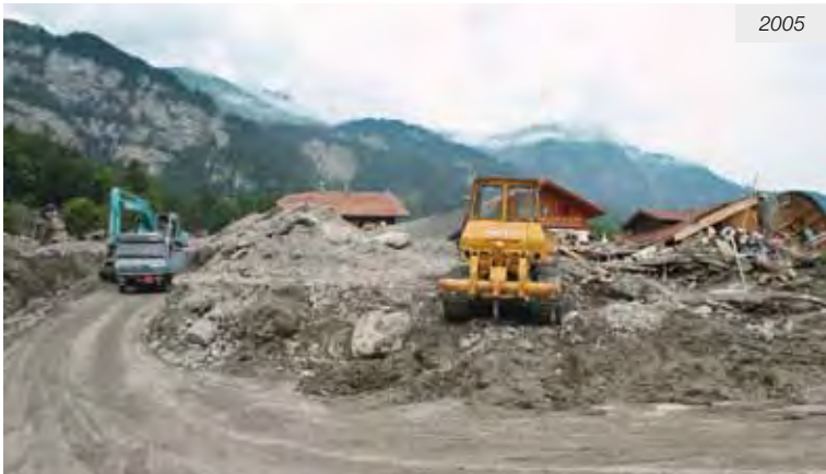
Einmündung der Schwanderstrasse in die Hauptstrasse.
