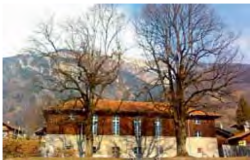
Alte Turnhalle, Baujahr 1937/1938.
