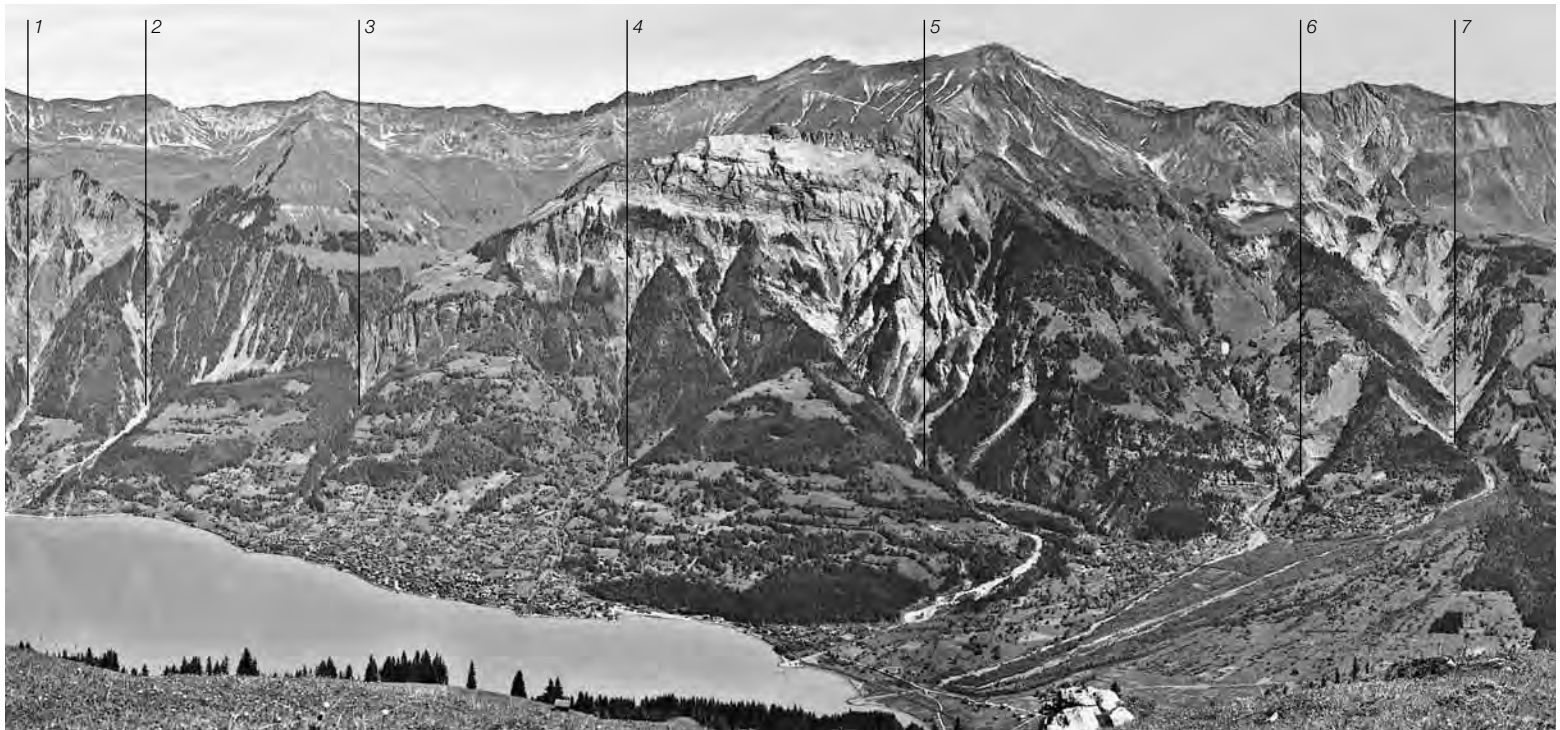
Brienzner Wildbäche von links nach rechts: Ofenbielen (1)- und Hellgraben (2), Mühlebach (3), der aufgeforstete Trachtbach (4), der mächtige Glyssibachgraben (5), der gut aufgeforstete und verbaute Schwanderbach (6) und der gewaltige Lammbachgraben (7).
