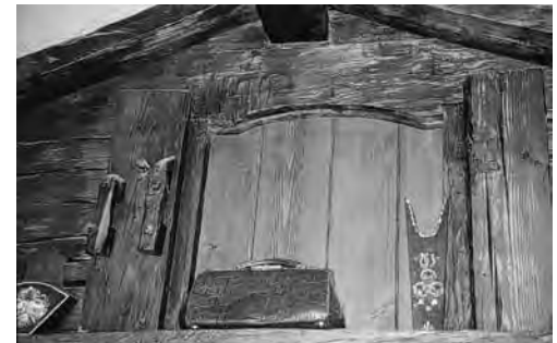
Die ursprünglich durch ein Türchen verschliessbare Öffnung zwischen der bis zum Dach offenen Küche und der «Ruessdili» (Russdiele) unter der First des Hauses Krummgasse 3 aus dem Jahr 1561.
