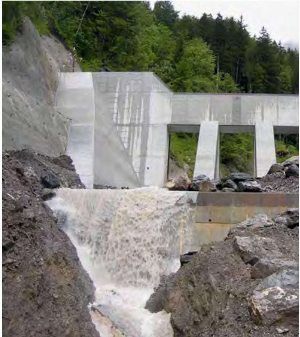
Das Ausleitbauwerk Undersitsch wurde 2010 fertig gestellt.
