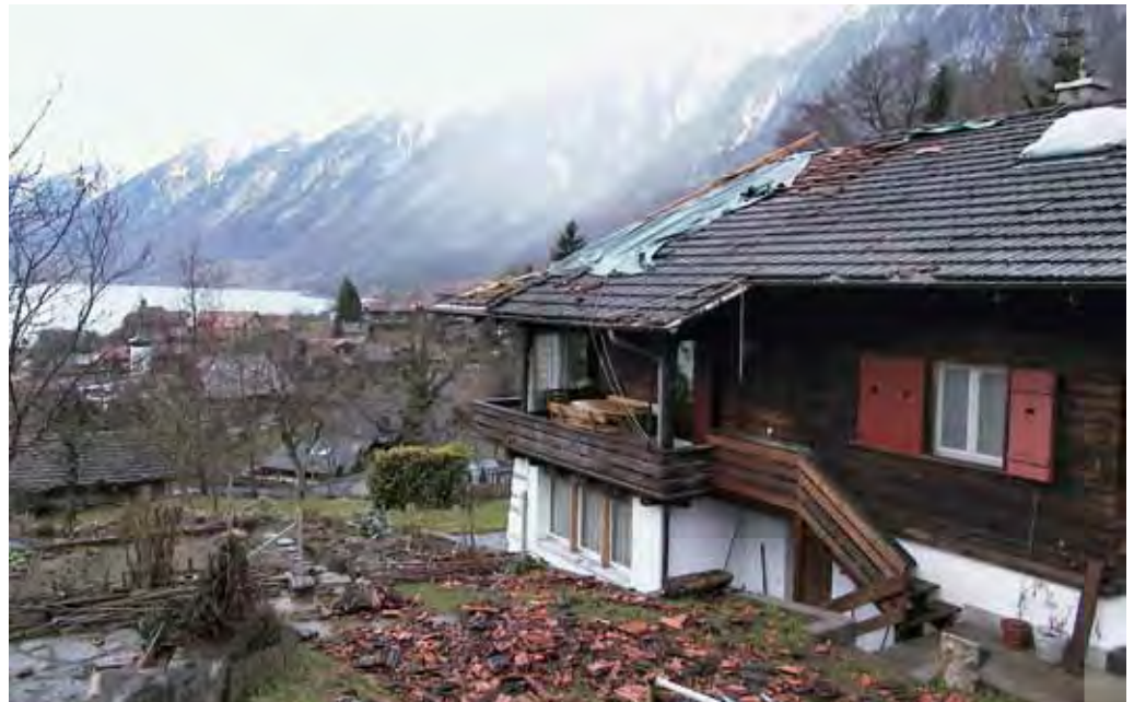
... forderte erste Schutzmassnahmen und grosse Räumungsarbeiten.
