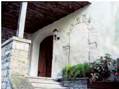
Alter und neuer Nordeingang.
