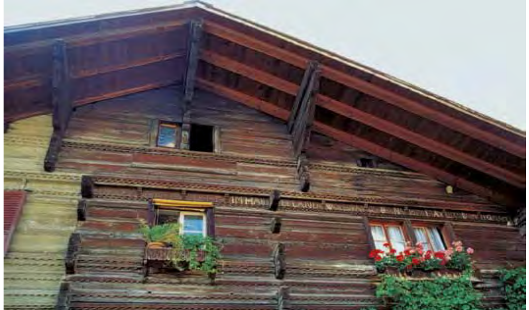
Die mit zahlreichen Rautenfriesen beschnitzte Front des um 1640 erbauten Hauses an der Hauptstrasse 15. Die Inschrift ist durch feine Konsölichen unterbrochen. An den Gwättvorstössen ist das grosse drei Stuben breite Haus zu erkennen.
