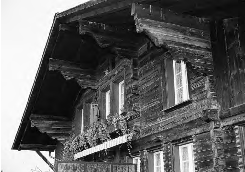
Die fünf dreifachen «Rosskopfkonsolen» am Haus Oberdorfstrasse 36/38 von 1553. Unter der erneuerten Jahrzahl ist das Gesims mit den feinen Rillen erkennbar, und die Blockvorstösse belegen eine breite und eine schmale Kammer.
