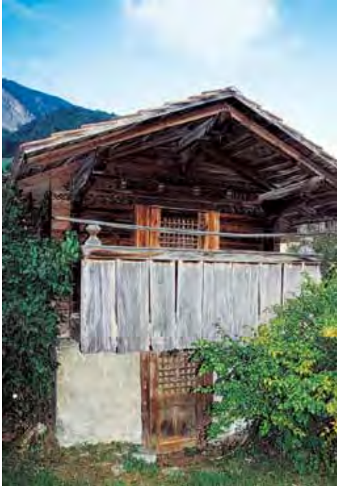
Im Giebfeld reich verzierter Speicher an der Oberdorfstrasse 53.
