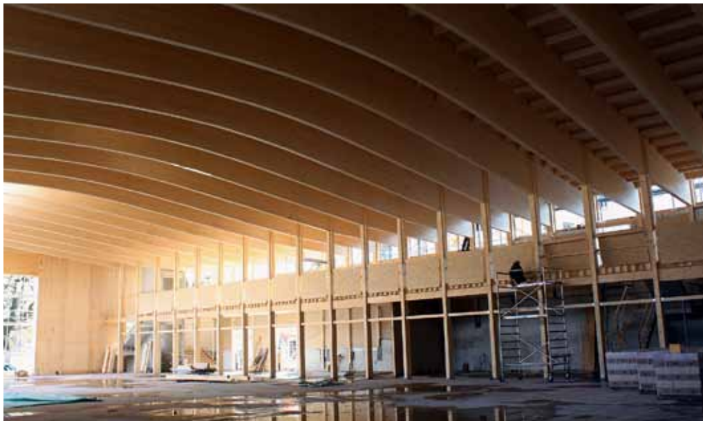
Charakteristische Holzkonstruktion der neuen Halle (Rohbau, Herbst 2009).
