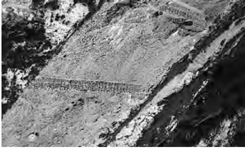
Mit Sperrmauern aus Drahtkörben wird der steile Schuttstrom zum Stillstand gebracht.
