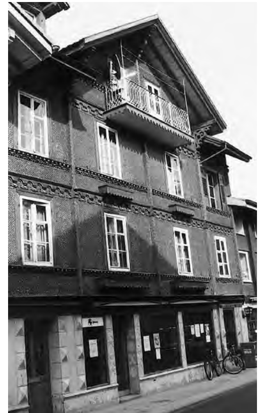
Das um die Jahrhundertwende unter dem Einfluss des Schweizer Holzstils erbaute Gusset-Haus an der Hauptstrasse 59.
