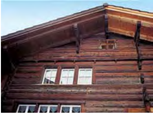
Fassadenteil an der Äusserstgasse 3 mit den Würfelfriesen und den ursprünglichen Fenstergewänden des Gadengeschosses.
