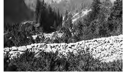
Blick hinunter in einen verbauten und aufgeforsteten Teil des Glyssibachgrabens.
