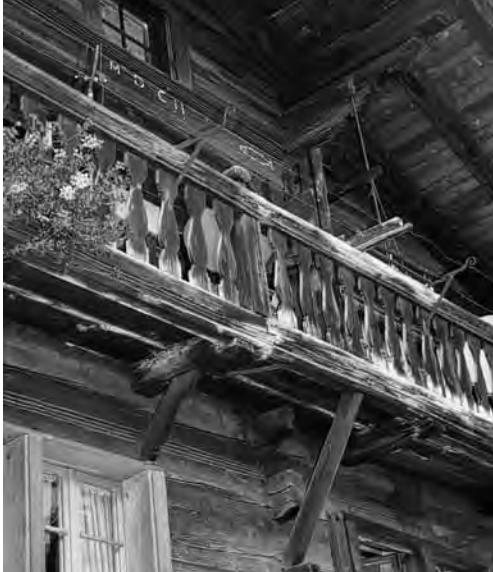
Die «Sommerlaube» am Haus von 1602 an der Brunngasse, die nachträglich mit Stichbalken und Bügen und mit auf die Blockvorstösse der Zwischenwand abgestützten Streben angebaut worden ist.
