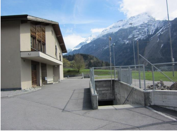
Ansicht Eingangsbereich „vorne“
